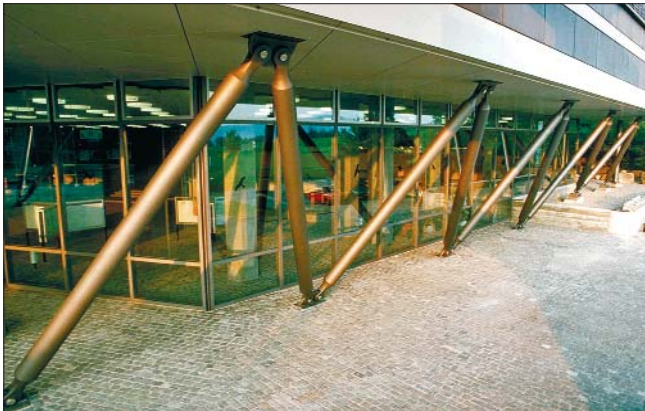
Hörsaalgebäude der ETH Zürich mit aussen angebrachten Fachwerk-Stahlstützen
