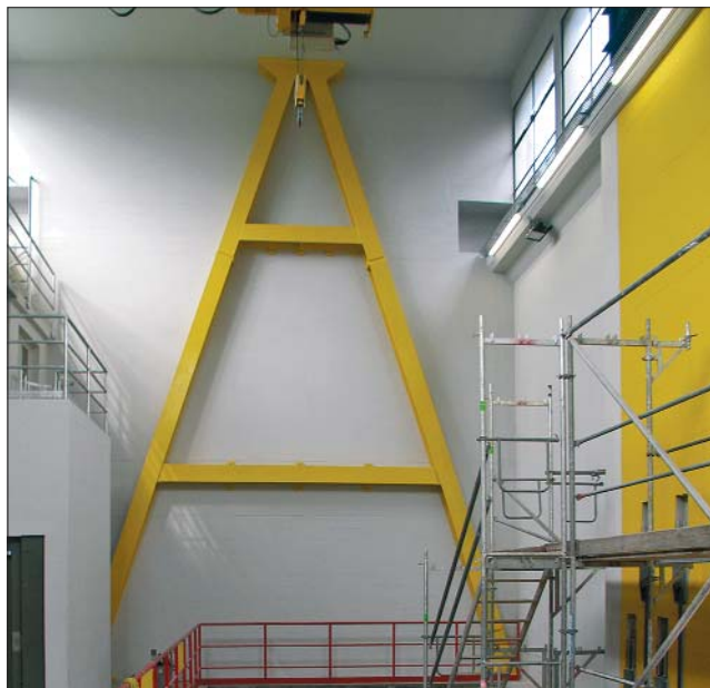
Elektrizitäts-Unterwerk mit «erdbebenbedingten», gelb angemalten neuen Tragelementen (siehe Text «Elektrizitäts-Unterwerk»)
